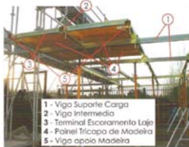
Cofragem metálica para madeira (lage)
